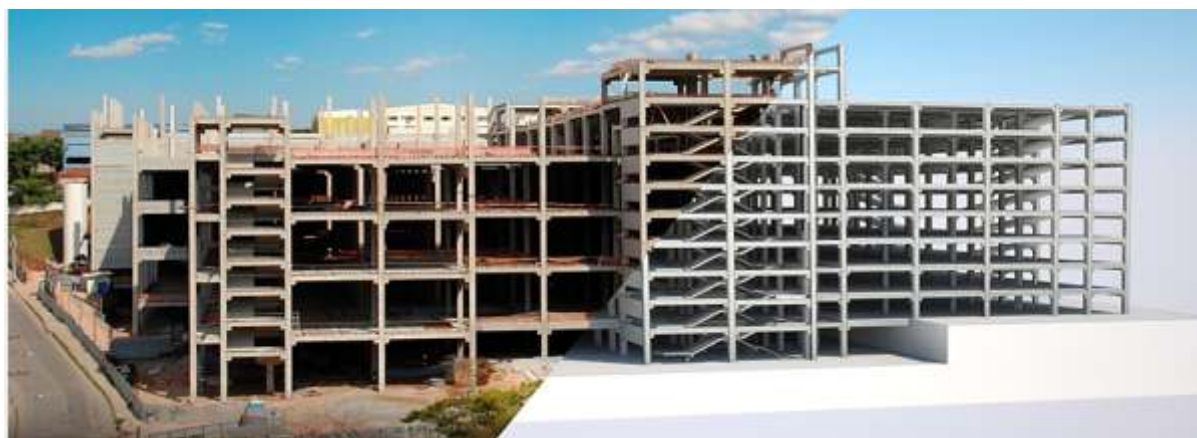
Imagem da obra executada e do modelo 3D
